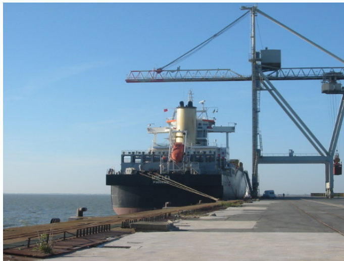
Terminal du Verdon (photo Grand Port Maritime de Bordeaux )
