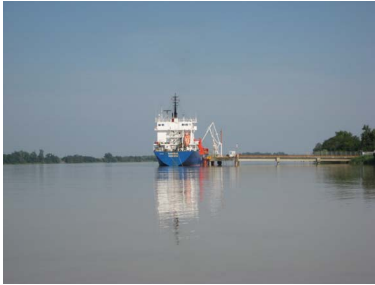
Vue appontement d'Ambès (photo du Grand Port Maritime de Bordeaux)
