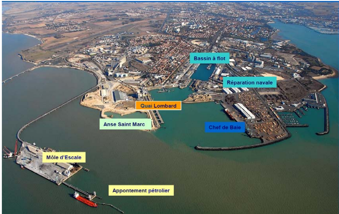
Figure 8 : Plan du Grand Port Maritime de La Rochelle (extrait de la présentation de Mr Plisson)
